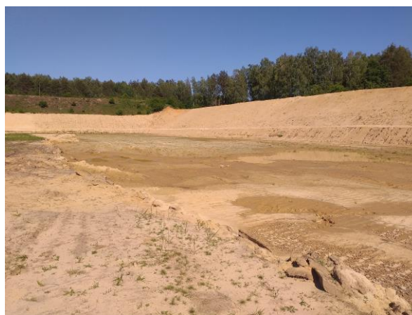
PRAWIE ZABEZPIECZENIE BOCZNE PRZYGOTOWANE DO ZABUDOWY ZADASZENIA KULOCHWYTU
