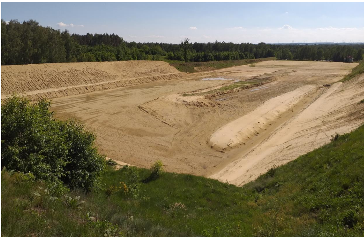
STREFA STRZELAŃ OSI NR 1 PO PIERWSZYM ETAPIE ROBÓT MODERNIZACYJNYCH
