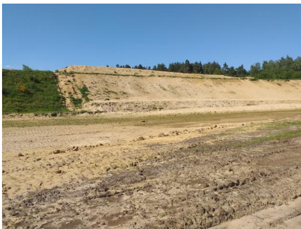
LEWE ZABEZPIECZENIE BOCZNE PRZYGOTOWANE DO ZABUDOWY ZADASZENIA KULOCHWYTU
