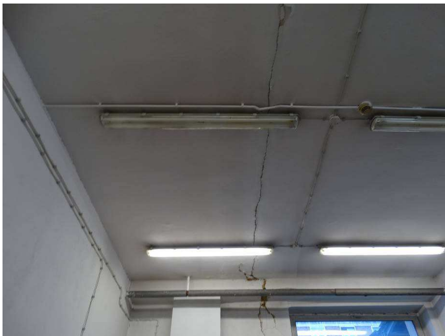
Fot.K2. Widoczne zarysowanie tynku na dylatacji stropu i na ścianie pod dylatacją stropu.
