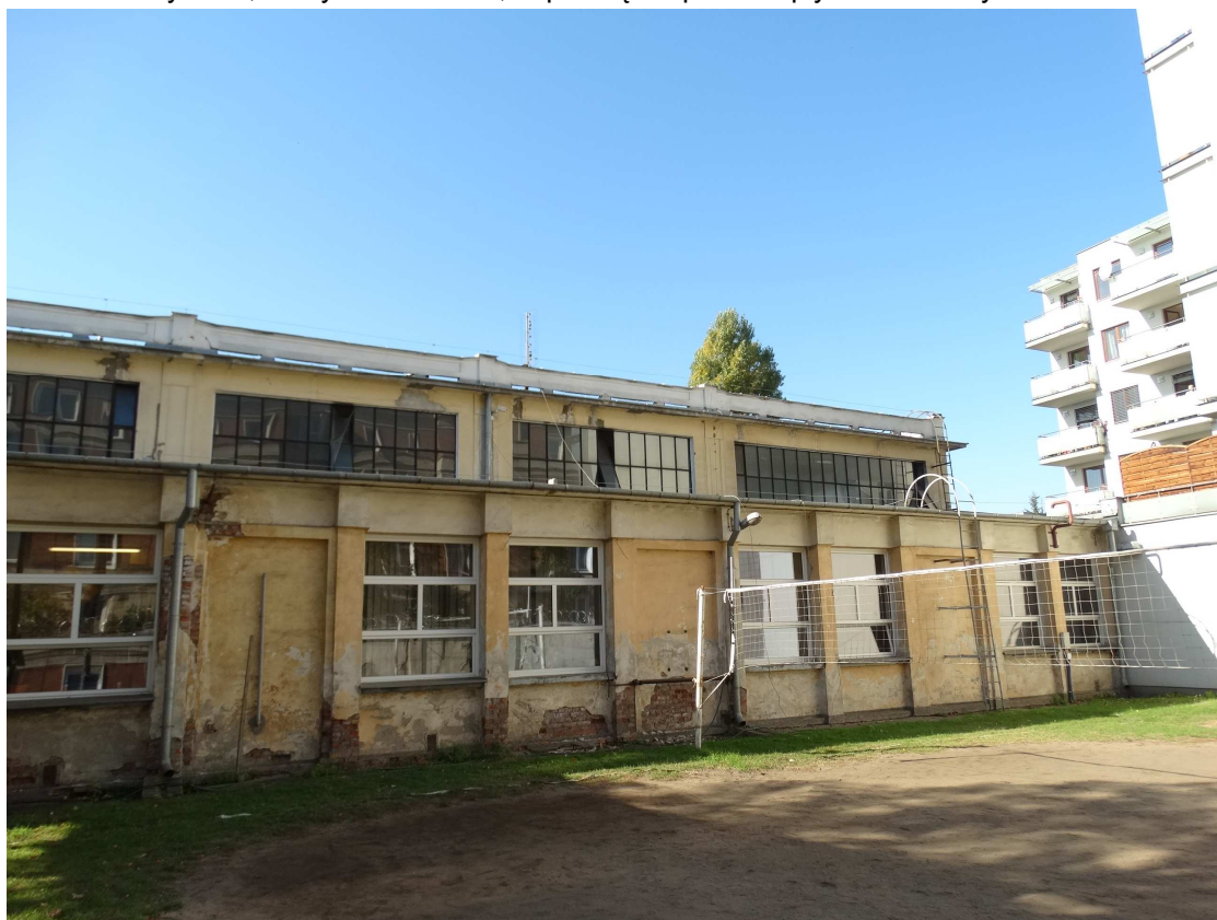
Fot.E2. Zdjęcie poglądowe wystroju i uszkodzeń na fragmencie elewacji wschodniej. Widoczne ubytki tynków, cegły, lastryko na cokole, zapadnięta opaska z płyt chodnikowych.
