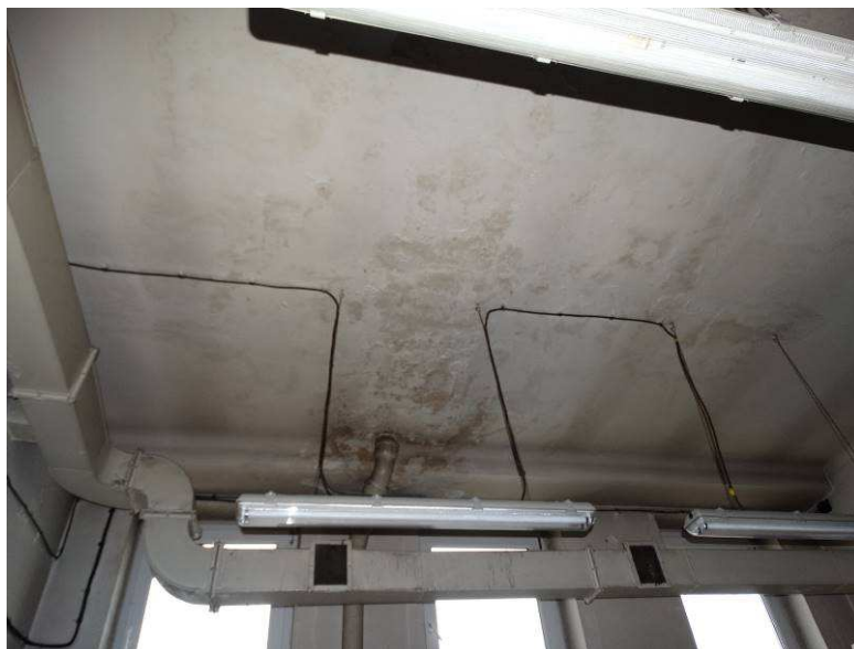
Fot.K5. Widoczne zacieki na stropie szatni związane z nieszczelnym pokryciem.
