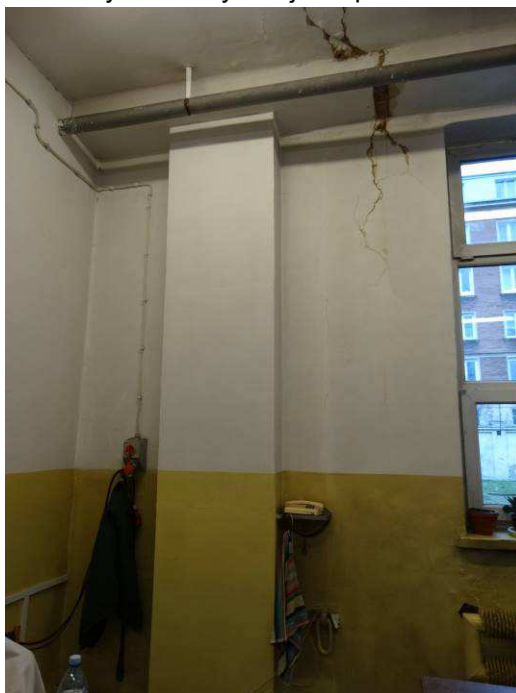
Fot.K2a Widoczne zarysowanie ściany w pom. nr 21, która nie jest dylatowana pod stropem, który to jest zdylatowany.
