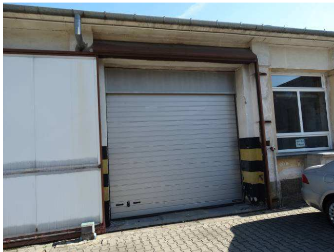
Fot. B1. Widoczna stara brama zewnętrzna i od wewnątrz zamontowana nowa brama segmentowa.
