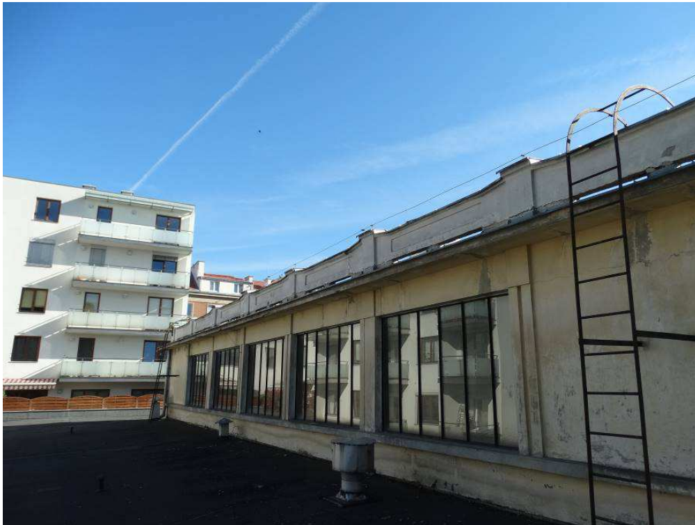
Fot. E4. Zdjęcie poglądowe wystroju elewacji zwyżki na przykładzie elewacji północnej. Widoczne spękania tynków i złuszczenia powłok malarskich.
