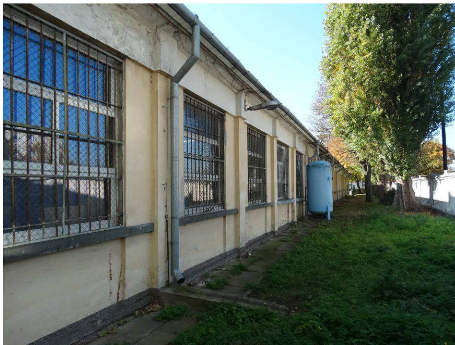
Fot.E1. Zdjęcie poglądowe wystroju elewacji na przykładzie elewacji północnej. Widoczne ubytki tynków, lastryko na cokole, zapadnięta opaska z płyt chodnikowych.
