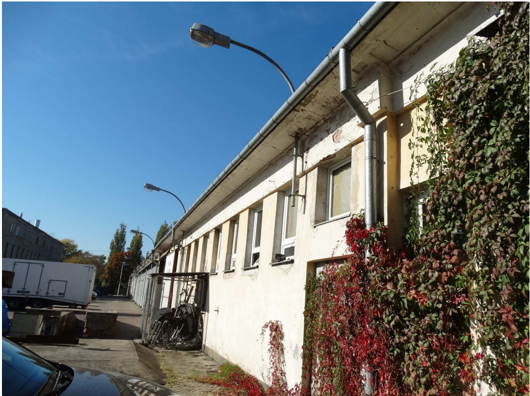
Fot.E2. Zdjęcie poglądowe wystroju i uszkodzeń na fragmencie elewacji południowej. Widoczne ubytki tynków, zacieki na gzymsie i elewacji.
