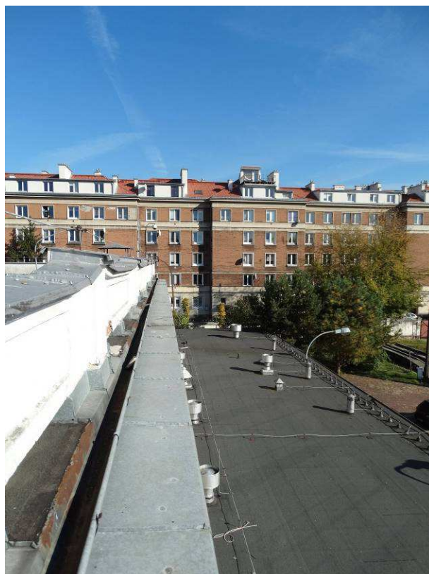
Fot. D4. Zdjęcie attyki i okapu dachu zwyżki. Widoczna korozja obróbek blacharskich, ubytki tynków na ścianie attyki.
