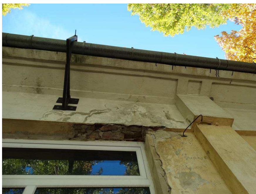
Fot.K4. Widoczne zarysowanie nadproża i ubytek cegieł w nadprożu Kleina na elewacji północnej.
